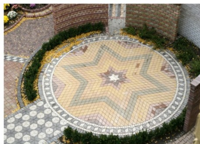
3. Пример укладки тротуарной плитки в виде круга для “пяточка” у пирса.
