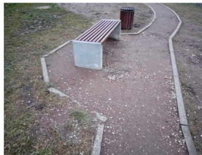
2. Пример укладки витиеватых дорожек с гибким поребриком.
